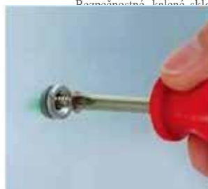
3) Sklo ukotvíte pomocou predného dielu bodového úchytu a bežnej skrutky priemeru 4mm so zapustenou hlavou.
